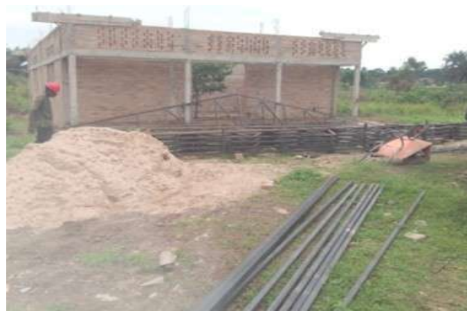
Construction de la Miellerie
